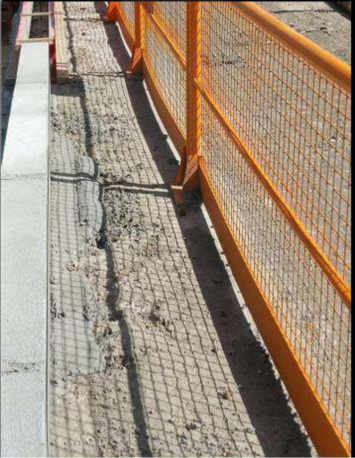
Handrail Edge protection 1.1M High
